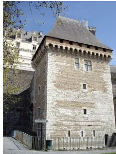
La tour de la monnaie du château de Pau
